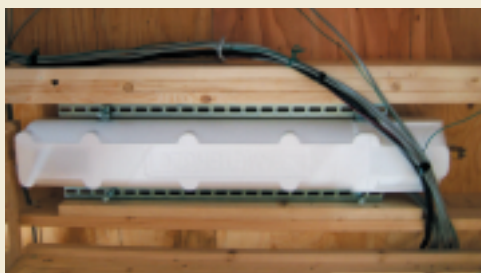
下から見た取付の状態 2本のレールに4本のボルトで固定(オプションの木造住宅用金具を使用)
