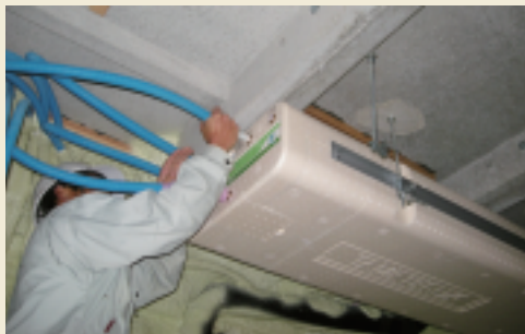
給水管の取付け(ワンタッチで接続可能な継手を内蔵)
